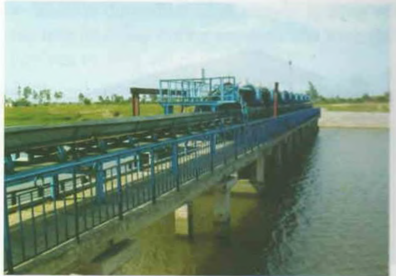
Hình 4. Thiết bị VRx - 01 tại Trạm bơm Vĩnh trị - Hà Nam
